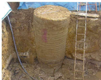
図 4 機械攪拌工法の改良体掘出し状況 ：アスコラム工法の例
