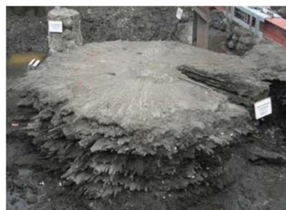
図 5 高圧噴射攪拌工法の改良体掘出し状況 ：JETCRETE の例
