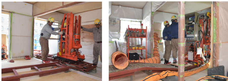
図8 エコタイト-Sの屋内施工例
